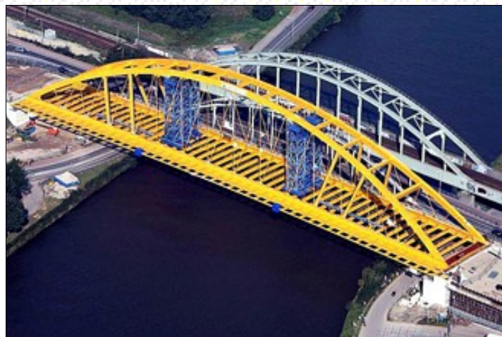
Figuur 1: de Hogeweidebrug van bijna 3.000 ton in Utrecht, uitgevoerd door Victor Buyck Steel Construction nv
